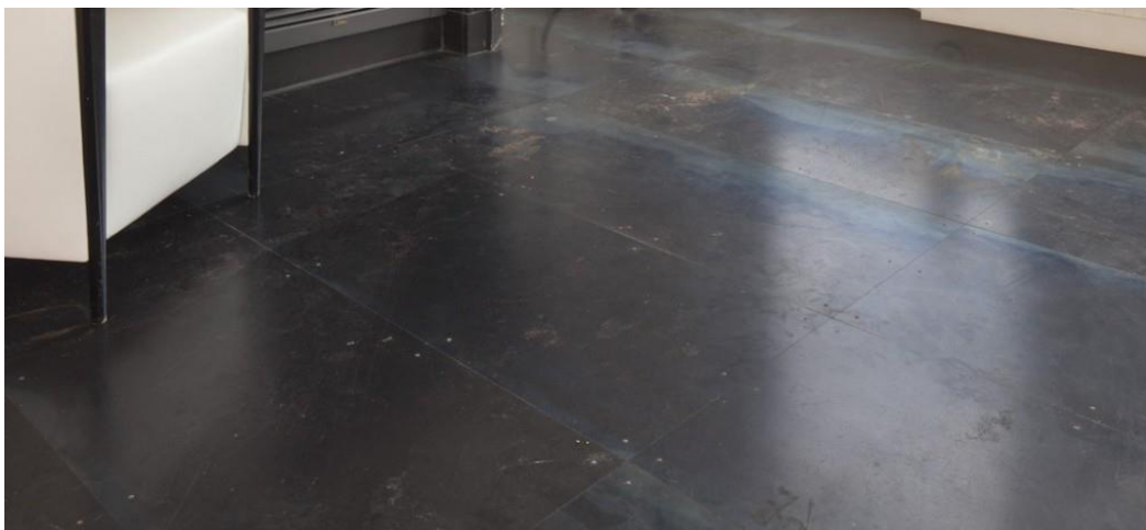
Foto: voorziening van aan elkaar gelaste metaalplaten
