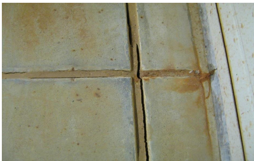
Foto: beschadigde kitvoeg
