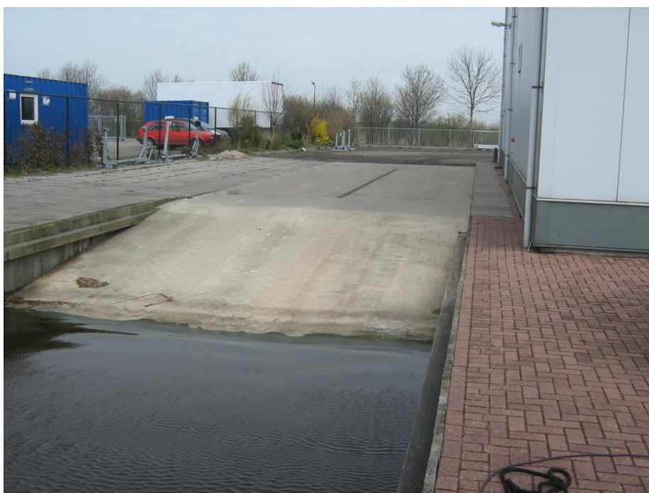
Foto: voorbeeld aandachtspunt afschot richting oppervlaktewater.
