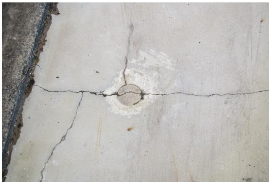
Foto: voorbeeld scheurvorming.
