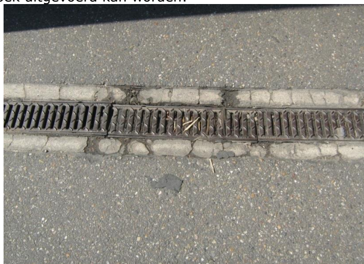
Foto: aansluiting met lijngoot niet vloeistofdicht afgewerkt
